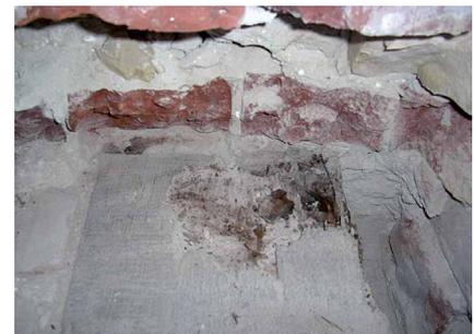
Abb. 6: Freigelegter Holzbalkenkopf in der Westwand; Schädigung im äußeren Bereich des Holzbalkens (Fotos: Architekt Matthias Thürigen)
